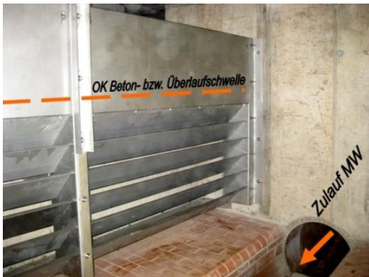
Typ LTW – T an der Überlaufschwelle im Regenüberlauf
