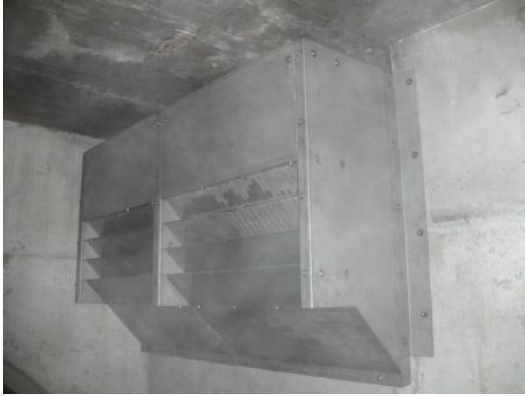
Typ LTW – V am Beckenüberlauf im Staukanal mit oben liegender Entlastung
