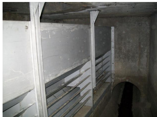
Typ LTW – T an der Überlaufschwelle im Regenüberlauf
