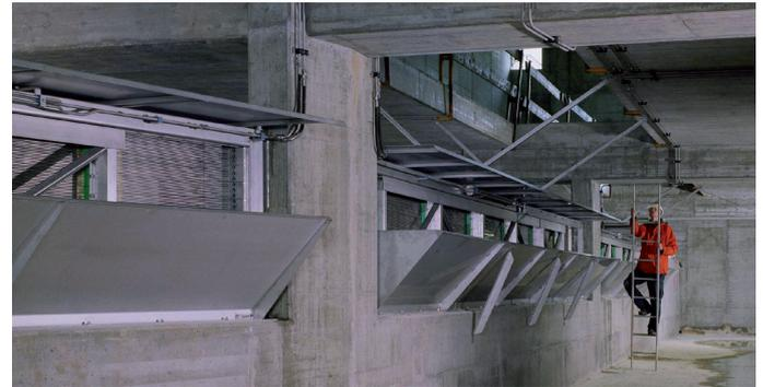
Einlaufkanal der ARA Aire in Genf, 3 RSW10X8/4, Q<sub>max.</sub> gesamt = 18'000 l/s
